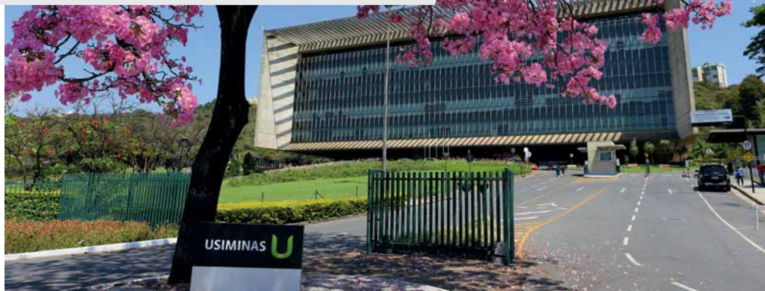
Sede Usiminas, Belo Horizonte/MG.
