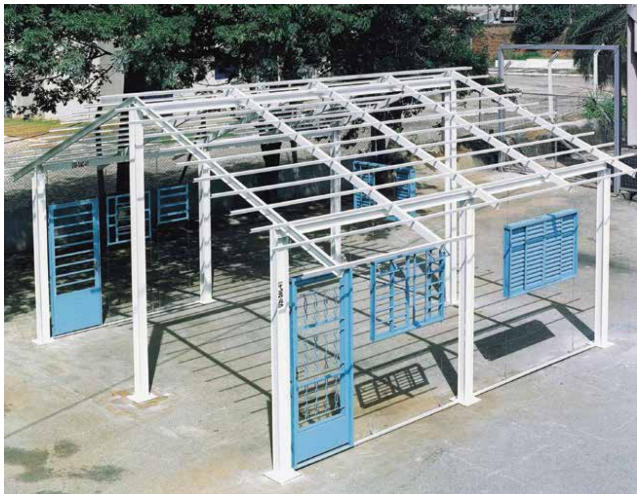
Estruturas em aço para residências.
